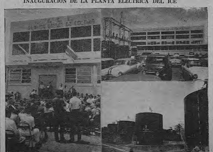
La Cámara de Eos captó distintos aspectos de las ceremonias que se llevaron a cabo el domingo en Colima, con motivo de la inauguración de la planta eléctrica Diesel construida por el ICE. En primer lugar puede observarse la elegancia del edificio de la planta, cuya arquitectura da idea de buena gusto y de progreso. Abajo aparece parte de la concurrencia escuchando el discurso de don Elias Quirós, Presidente de la Directiva del ICE. Finalmente, sobresalen majestuosamente los cuatro gigantescos tanques donde se deposita el Aceite Diesel que mueve la planta eléctrica.
